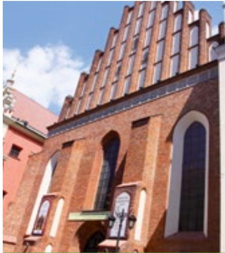
Die Fassade der Kathedrale erinnert an Gotik – unter den Ziegeln befindet sich jedoch eine Betonkonstruktion
