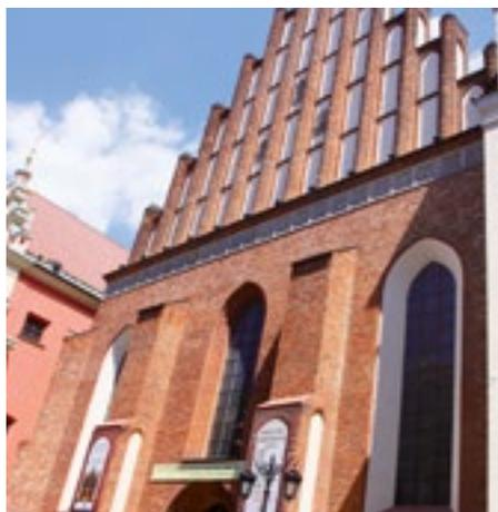
Фасад кафедрального собора лишь напоминает готический – под кирпичом видна бетонная конструкция
